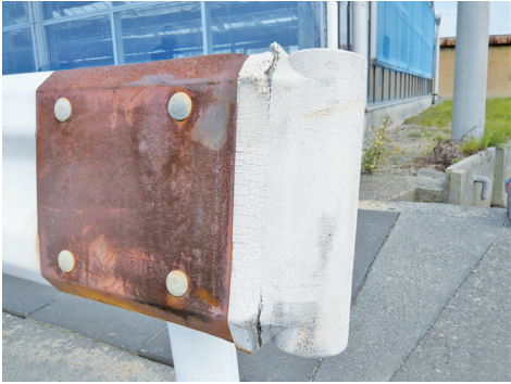
① 既設の袖を取り外す
