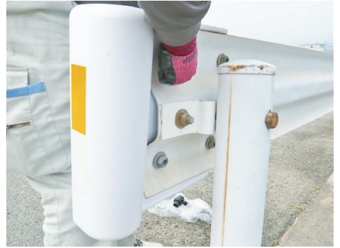
③ プロテクトガードを取付けていきます
